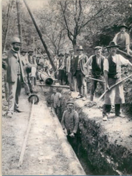
»WASSER MARSCH!« hieß die Devise beim Wasserleitungsbau anno 1906 im Jenaer Mühltal – »Wasser marsch!« lautet auch der Name der neuen Ausstellung im Jenaer Stadtmuseum
