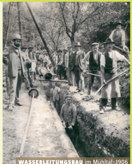
WASSERLEITUNGSBAU im Mühlthal, 1906
