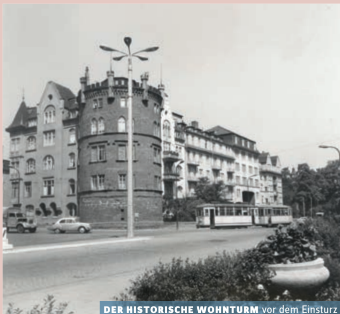
DER HISTORISCHE WOHN TURM vor dem Einsturz
