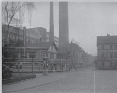
ZU HOCH FÜRS FOTO: Der Ziegel- und der Betonschornstein des Zeisswerks neben dem damaligen Café »Westend« eingangs der Goethestraße, 1937
